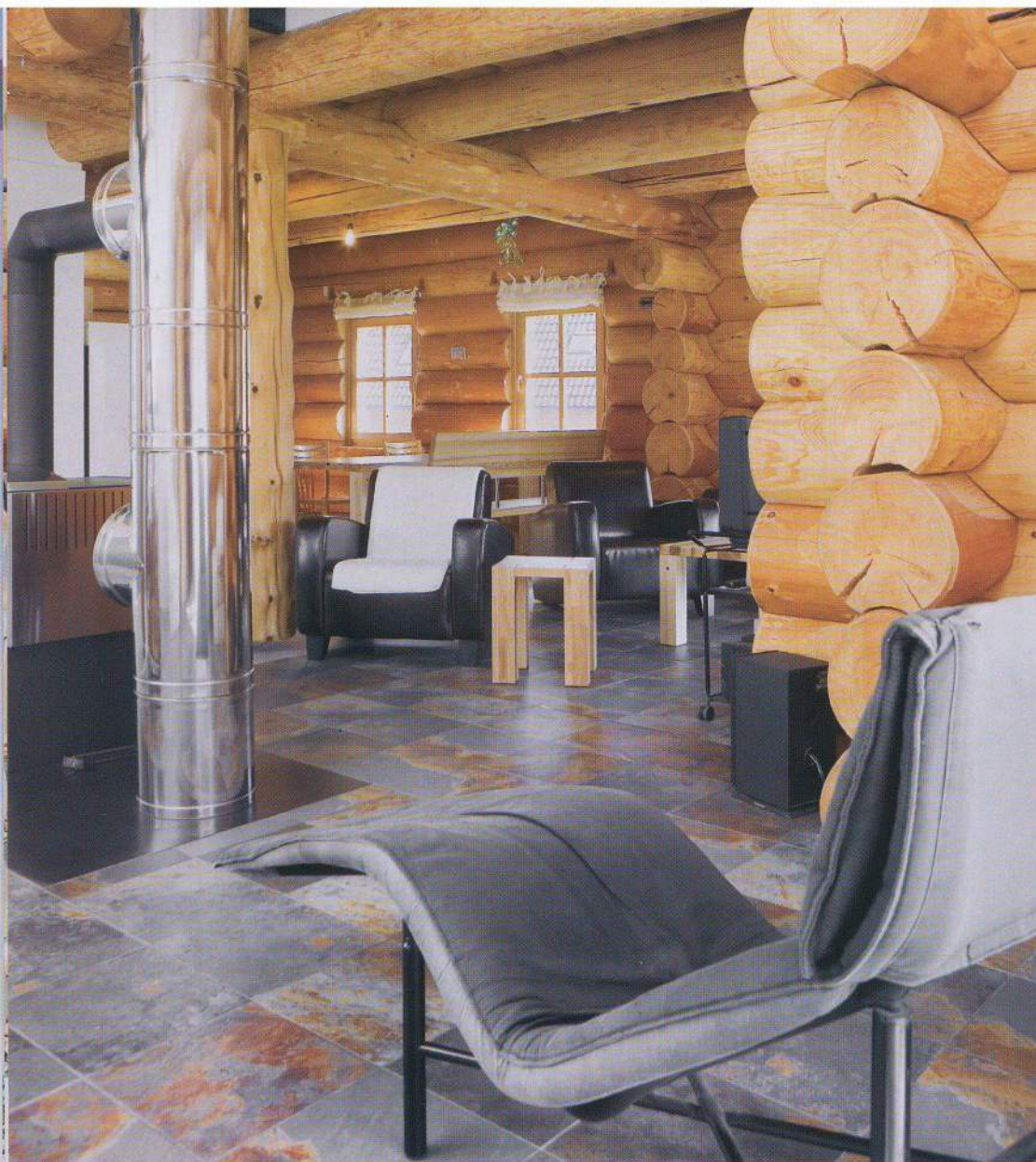
Nepřehlédnutelným prvkem interiéru domu je nerezový komín Schiedel.
